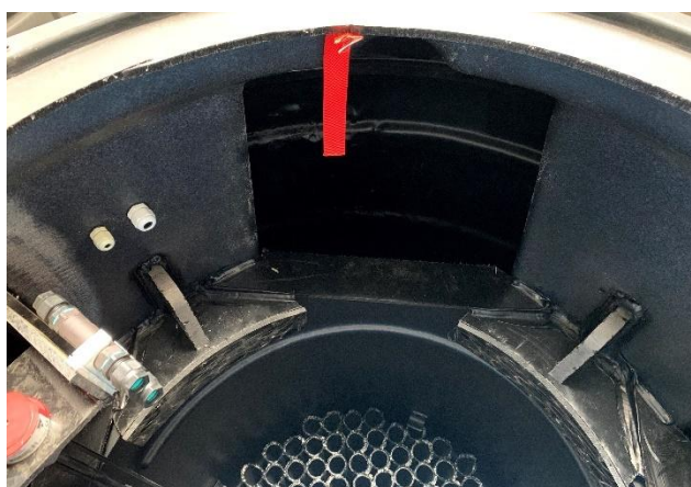
Bild 3: Märkning av det fack som ska slamtömmas.
