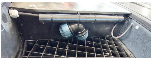
Bild 11: Kabeldragning för luftpumpen och värmekabeln ska ske genom förmonterad PEM-slang.
