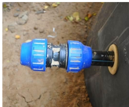
Bild 5. Anslutningen från vattenpumpen i ProACT® (till InterACT®) görs med 40 mm PEM-slang.
