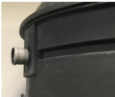
Bild 4. Inkommande rör till ProACT® från huset görs med standard 110 mm avloppsrör
