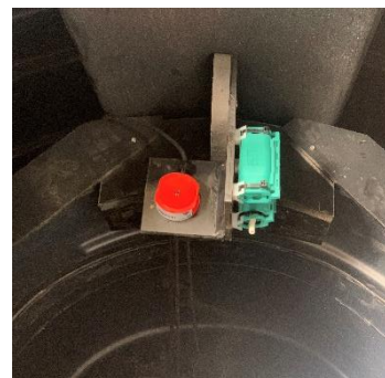
Bild 3: Gelkopplingar. Vattenpump och nivågivare ansluts i tanken med dessa och fästs med buntband på de små vita fästen som sitter där.
