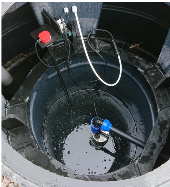
Bild 8. Vattenpumpens placering i ProACT®.
