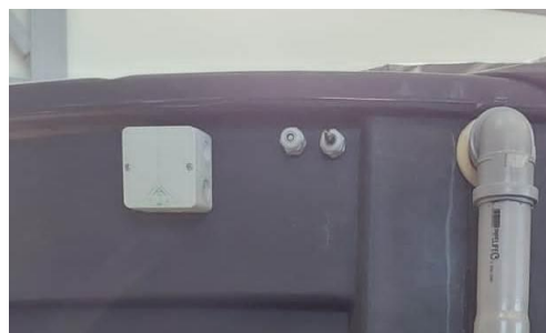
Bild 7: Kopplingsdosa utanpå InterACT, kabel från värmekabel samt luftpump ska dras genom genomföringarna och kopplas in i den vita kopplingsdosan.
