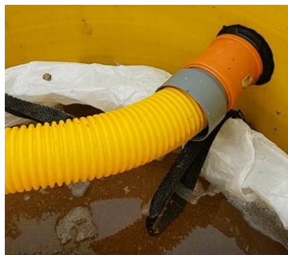
Bild 13: Koppling, inlopp i ReACT
