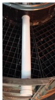
Bild 7. Utloppet från InterACT® är anpassat för standard 110 mm avloppsrör.
