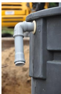
Bild 6. Inloppet till InterACT® är anpassat för 40 mm PEM-slang. Kör in slangens hela vägen fram till böjen.
