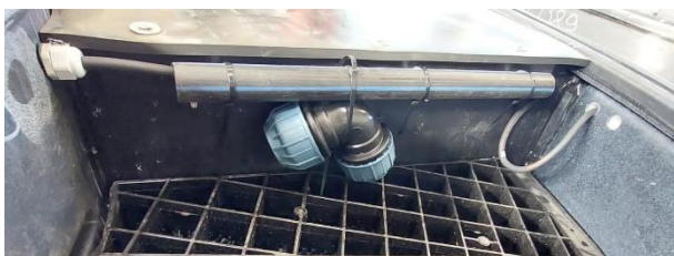
Bild 6: Kabeldragning för luftpumpen och värmekabeln ska ske genom förmonterad PEM-slang.
