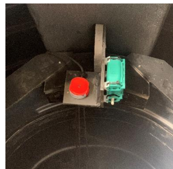
Bild 3: Gelkopplingar. Vattenpump och nivågivare ansluts i tanken med dessa och fästs med buntband på de små vita fästen som sitter där.
