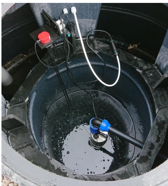
Bild 8. Vattenpumpens placering i ProACT®.
