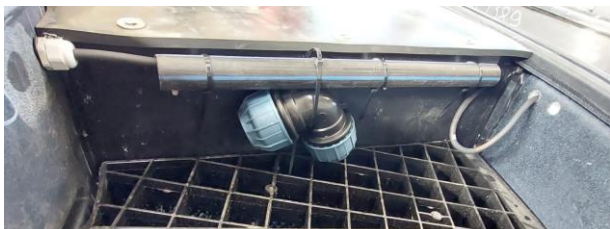
Bild 11: Kabeldragning för luftpumpen och värmekabeln ska ske genom förmonterad PEM-slang.
