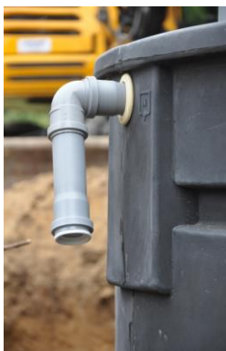
Bild 6. Inloppet till InterACT® är anpassat för 40 mm PEM-slang. Kör in slangen hela vägen fram till böjen.
