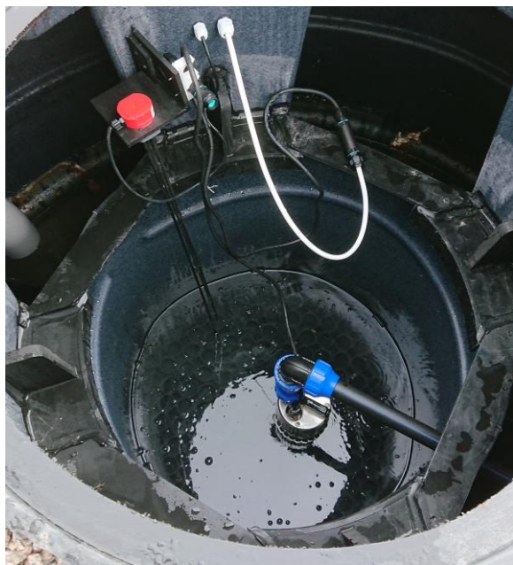
Bild 8. Vattenpumpens placering i ProACT®.
