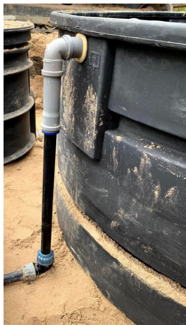
Bild 9. Slang mellan ProACT®/PumpACT® och InterACT® (Pem-slangen på bilden är förlagd med kort avstånd. Den raka kopplingen till höger i bild är redan monterad i anslutningen som visas i bild 5)
